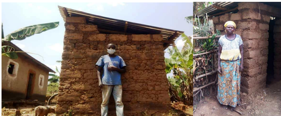
Photos des toilettes construites
