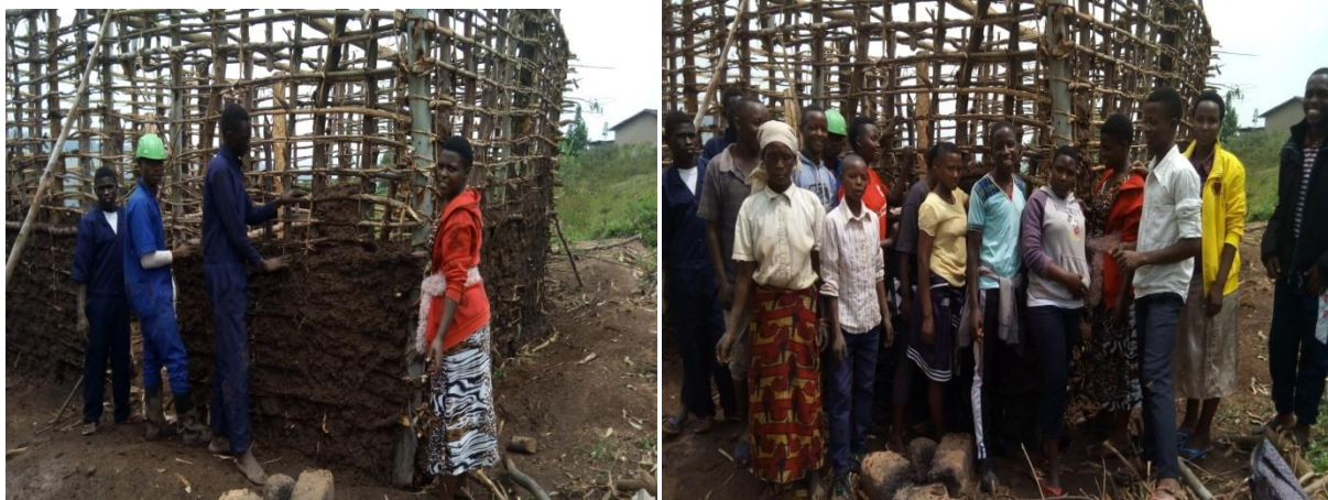
Photos des élèves en action de solidarité (les 4 de la photo 1 suivent la formation de maçonnerie)
