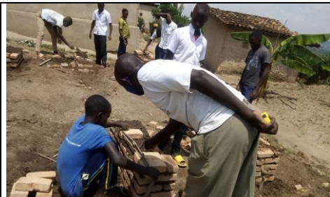
Les jeunes en construction guidés dans la pratique par des diplômés en maçonnerie
