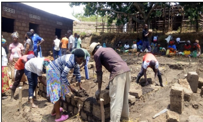
Le chantier avec les maçons diplômés anciens parrainés
