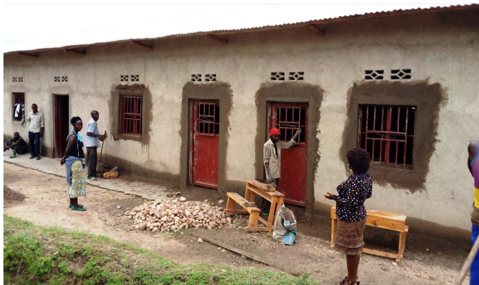
L'école des métiers en cours de travaux (12/5/2021)
