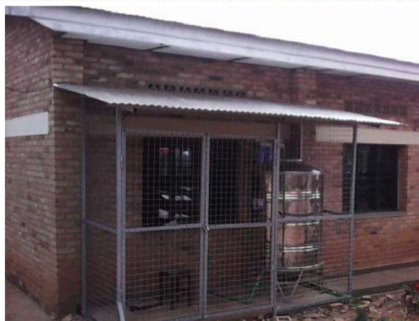
Citernes d'eau de pluie et filtre à Kiruhura (cf 1.5)
